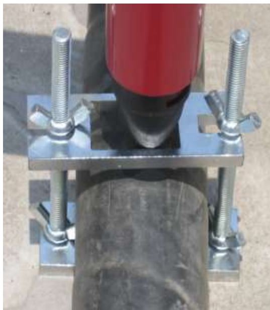
图 9 电缆夹具安装图
